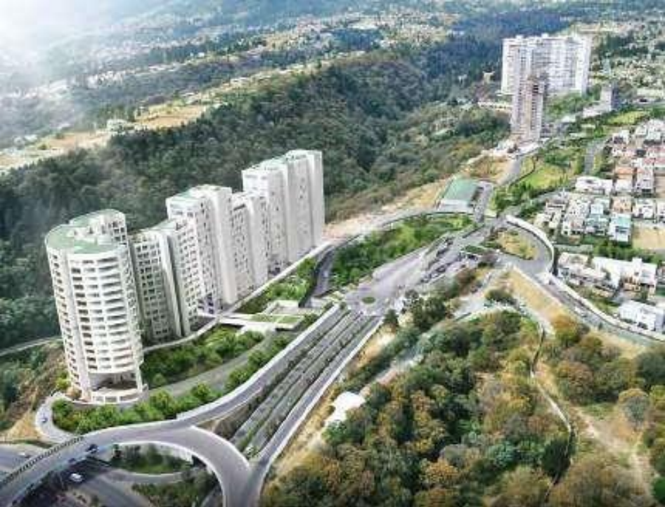
EDIFICIO BASALTO - CUMBRES DE SANTA FE
