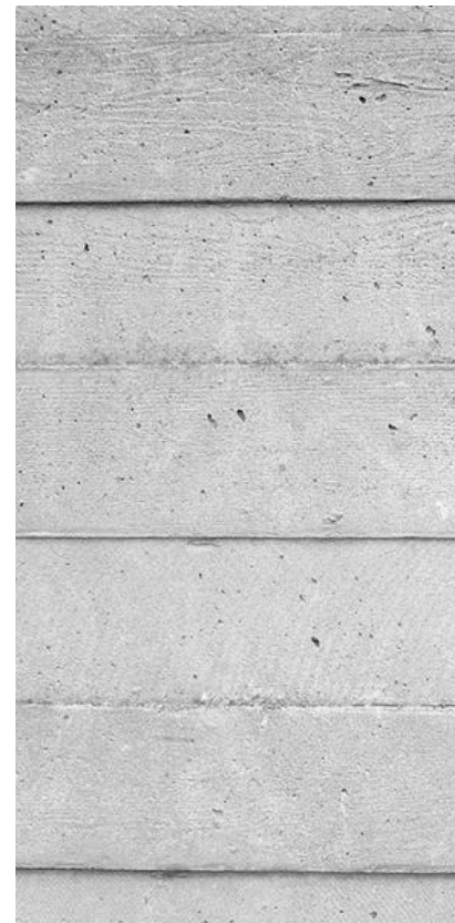
MURO DE CONCRETO
